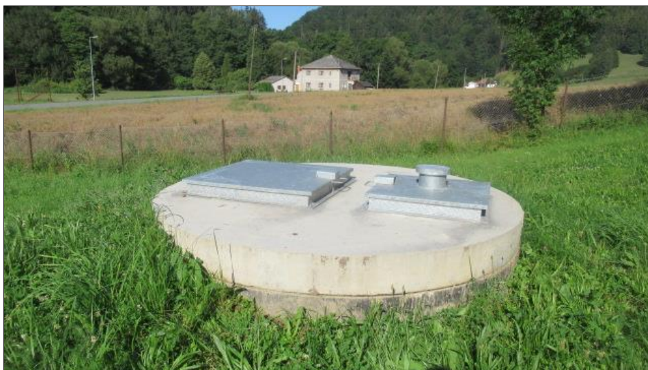
Nadzemní část vrtu Z4
